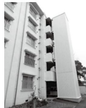
外付けエレベーター
