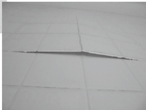
改修箇所(お風呂のタイル)
