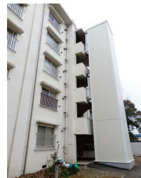
外付けエレベーター
