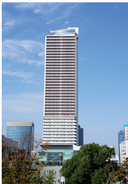
写真 参考1 岐阜タワー43外観
