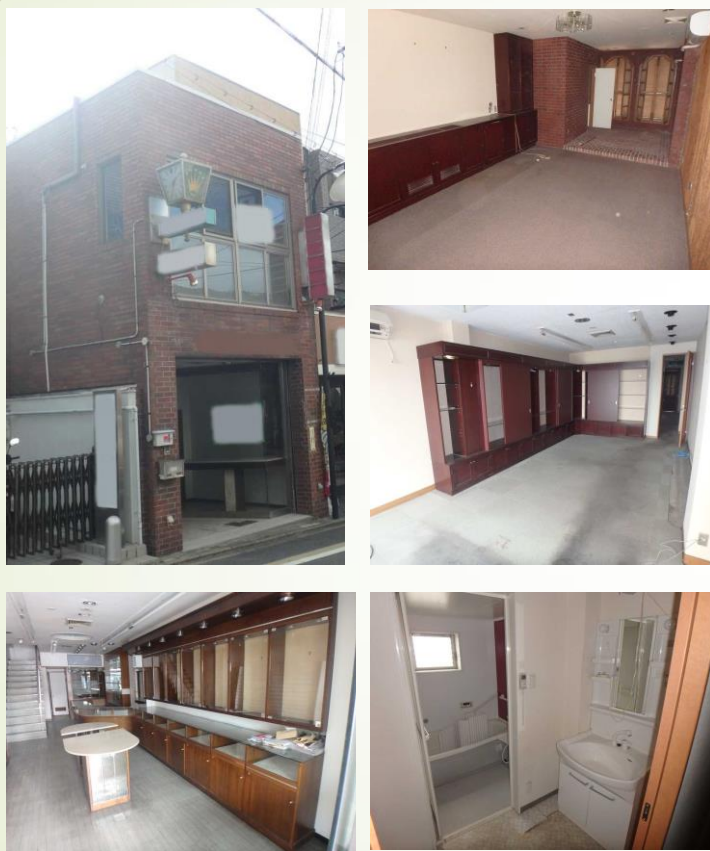
鉄骨造 2 階建 店舗付き住宅（築 3 9 年）
