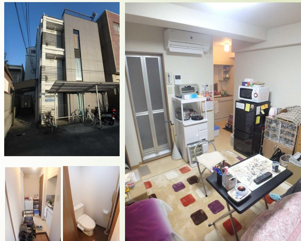
鉄骨造 4 階建 1 階部分 ワンルーム（築 2 1 年）
